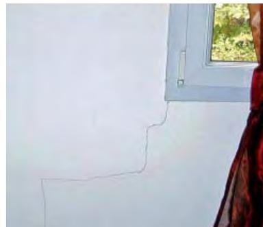
Figure 5 : Fissuration d'une cloison de doublage en briques. Si la façade est également fissurée au droit de cette ouverture, on peut conclure que l'on est en face d'un tassement.
