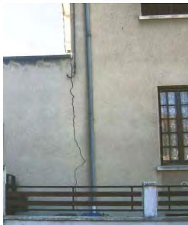
Figure 1 : Devant un désordre de cette ampleur, on emploie le terme « lézarde » pour qualifier la fissuration qui apparaît entre deux corps de construction.
