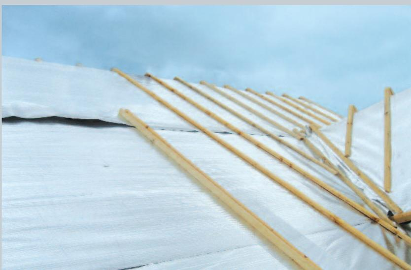
*Exemple de pose du Sun Reflex R3 avant mise en place de l'adhésif Soliflame*
